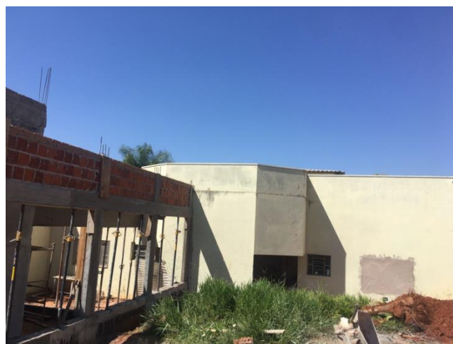
Fotos da ampliação e reforma da Cozinha Piloto
